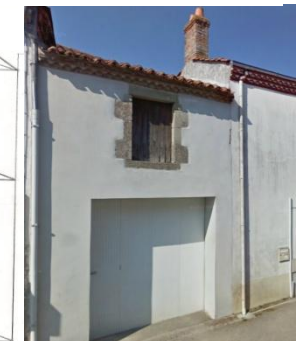
Projet 5: Réhabilitation d'un garage pour en faire un studio
