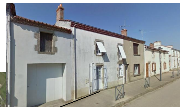
Photographie 12: Maisons ancienne à étage, rue de la Croix aux Forgerons, réalisation: A. LOISY
