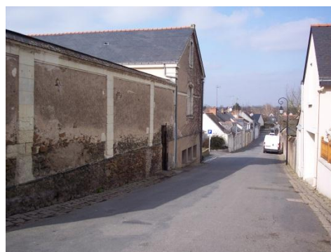
Figure 5 : Rue A. de Cumont
