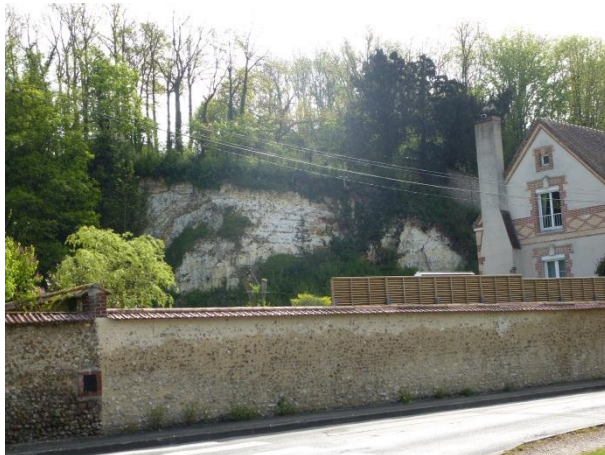
Photo 1 : "Falaise" au niveau du Coteau en contrebas de Bel-Air (source : BDepont)
