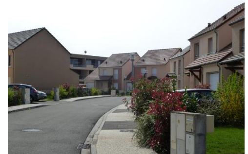
Photo 12 : Nouvelles constructions rues Hubert Latham (source : BDepont)
