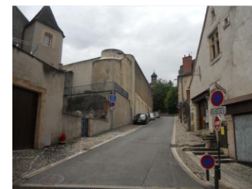
Figure 20 : de gauche à droite : escalier Place Piquand, escalier Rue du Petit Château et Rue du Château
