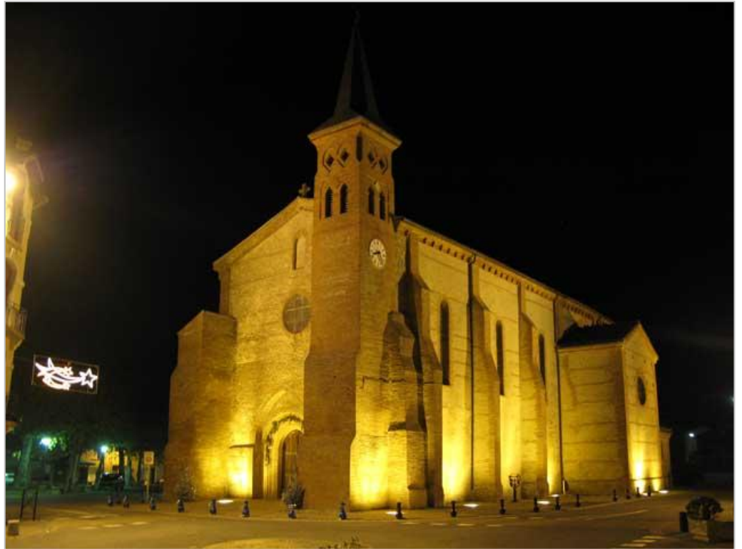
Photo 38 : Exemple d'éclairage par le sol 39
