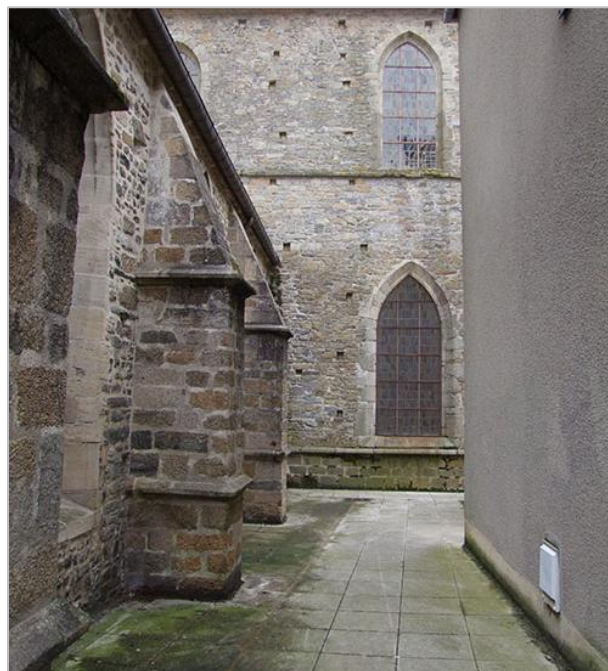
Photo 24 : Espace restant entre les constructions et l'église Saint-Nicolas
