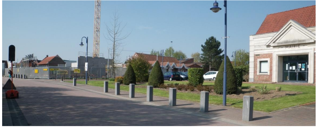
Photographie 9 : de gauche à droite : rue de l'Eglise, construction de la salle polyvalente, maison des associations, mairie
