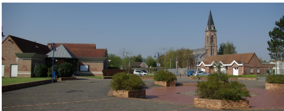
Figure 18 : place de Lompret, à gauche la mairie et à droite l'ancienne maison des associations pouvant accueillir le projet
