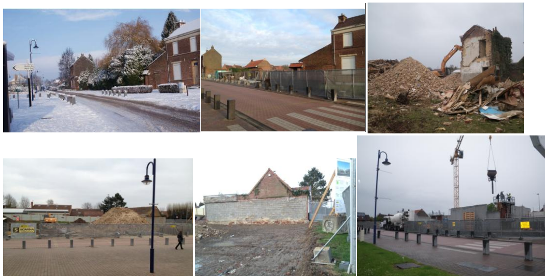
Photographie 8 : photographies de la destruction du presbytère et de la maison du directeur, pour la construction de la salle polyvalente
