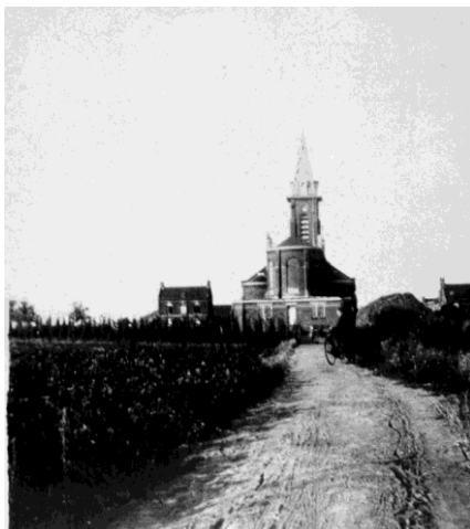
Figure 11 : Photographie avant la construction du domaine de Lompret [Source : archive de la mairiel]
