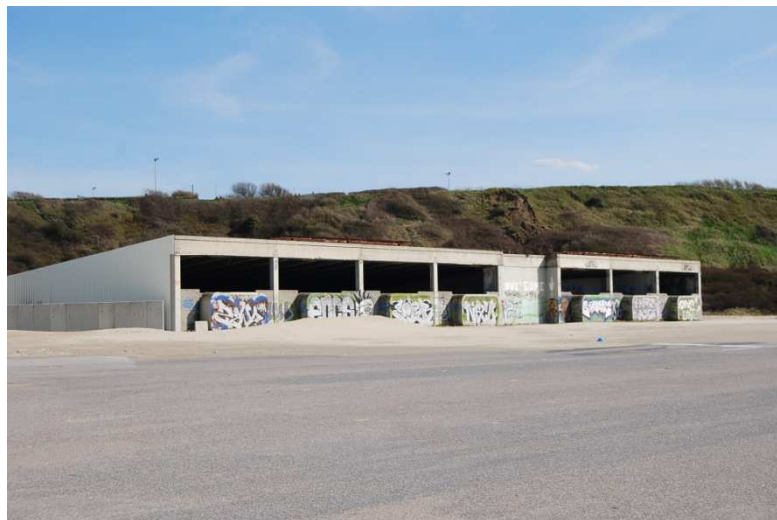
Photo 15 : Bâtiment de l'hoverport abandonné.
