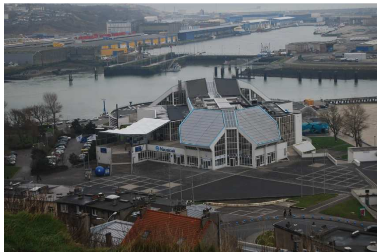
Photo 20 : Nausicaa à partir de la zone du futur parking
