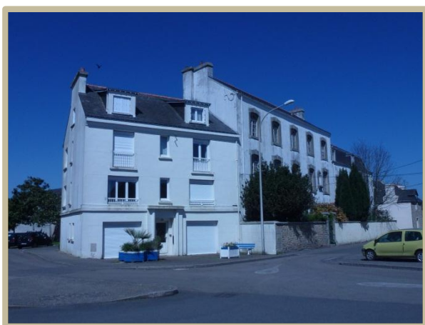
Photo 40 : Bâtiment 2 (source : Marie Le Scaon)
