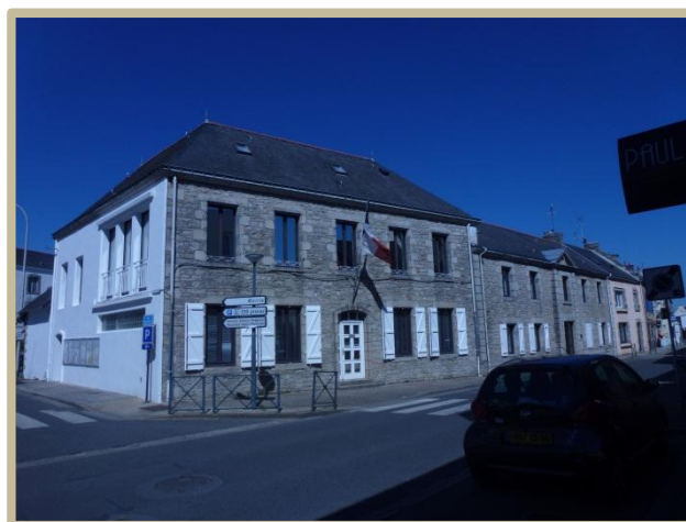
Photo 14 : Façade extérieure donnant sur la rue Ste Anne (source : Marie Le Scaon)
