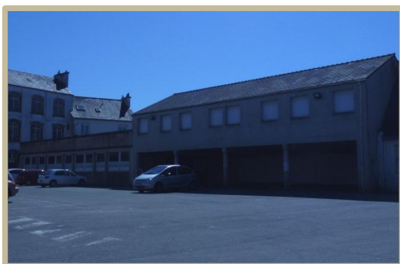
Photo 41 : Bâtiments 3 et 4 (source : Marie Le Scaon)
