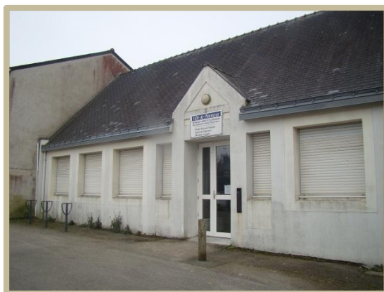
Photo 42 : Bâtiment 5 (source : Marie Le Scaon)
