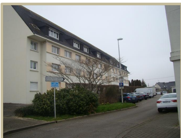
Photo 20 : Un des immeubles collectifs qui borde la rue Esvan (source : Marie Le Scaon)
