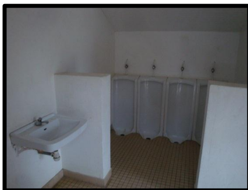
Photo 56, 57 et 58 : Les toilettes dépendantes du P'tit Caboulot, vues de l'extérieur et de l'intérieur Source : Photographies personnelles
