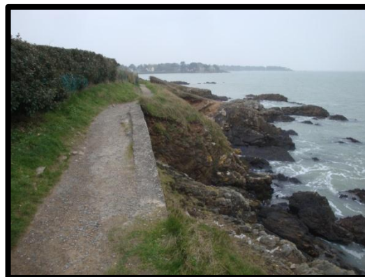
Photo 62 : petit passage bétonné le long de la côte, côté Ouest Source : Photographie personnelle
