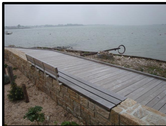
Photo 67 : Les aménagements le long du mouillage de Merquel Source : Photographie personnelle
