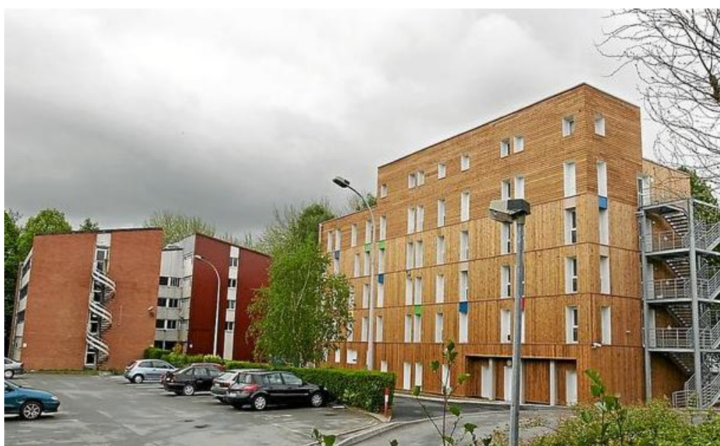
Figure 28 : L'unique bâtiment de la résidence Camus rénové.
