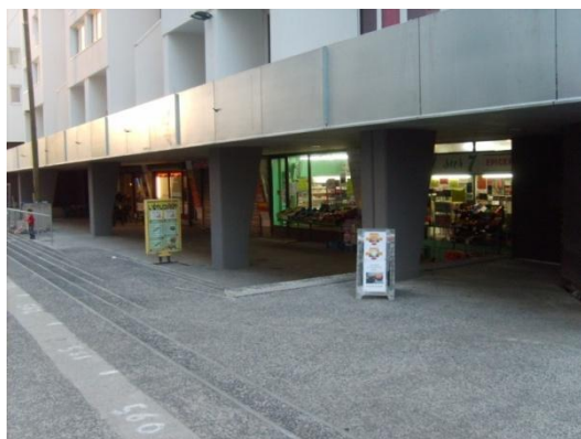
Figure 41 : Commerces de proximité sur la chaussée haute
