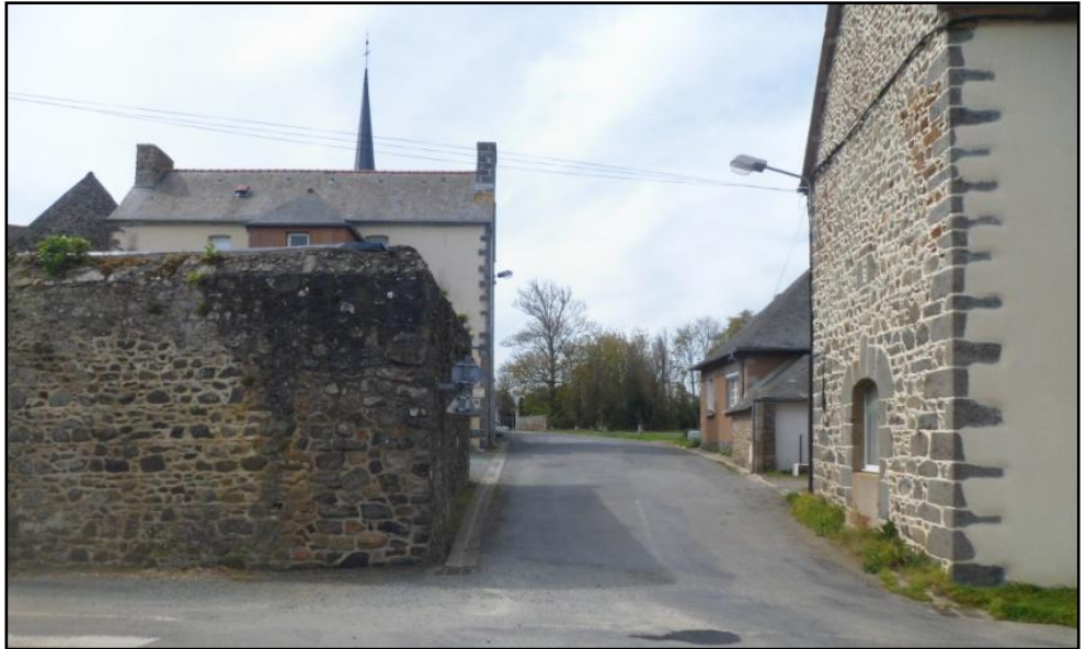
Photographie 32 : Les murs de pierres masquant la visibilité au carrefour de l'école, le panneau peu visible et le marquage absent Source : Morgane BEUREL
