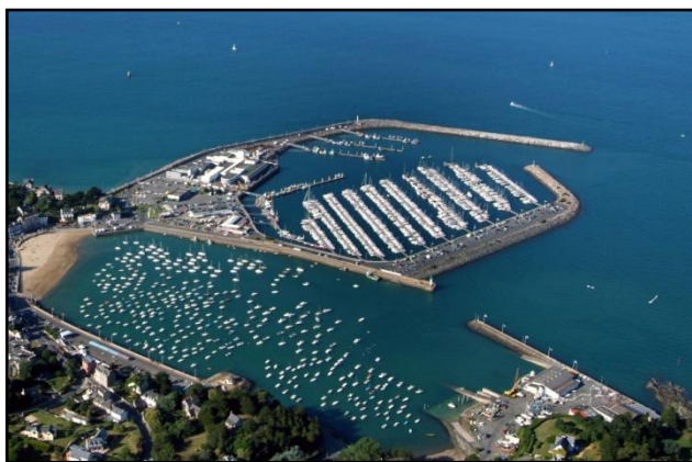
Photographie 14 : Vue aérienne du port de Saint-Quay Portrieux (« vieux port » et Port d'Armor) Source : www.bretagne-sports-international.com
