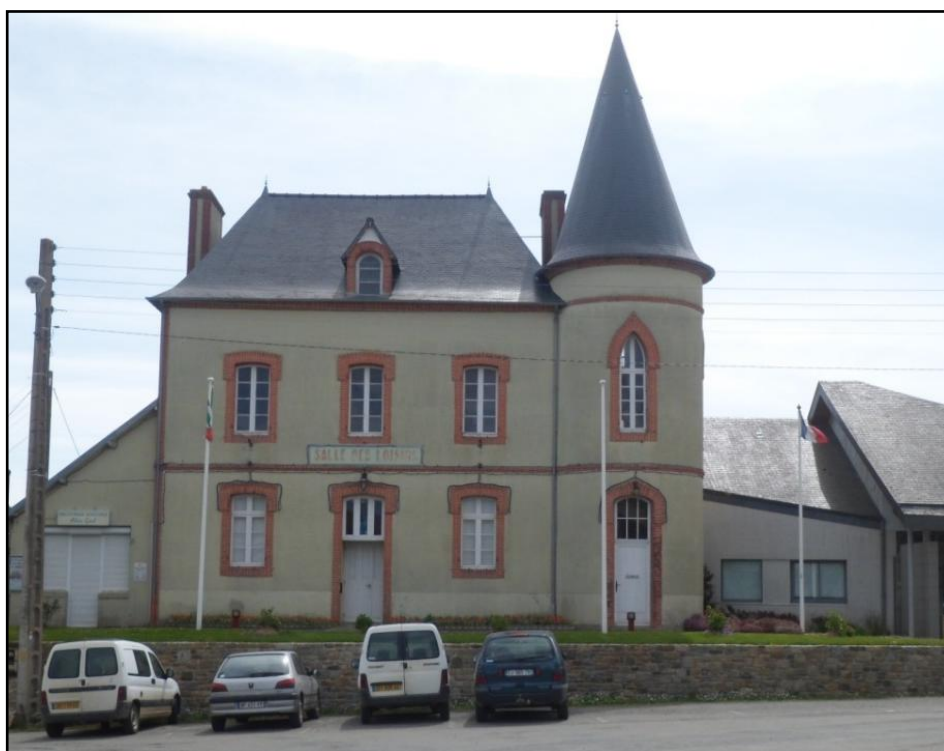
Photographie 30 : La salle des loisirs
