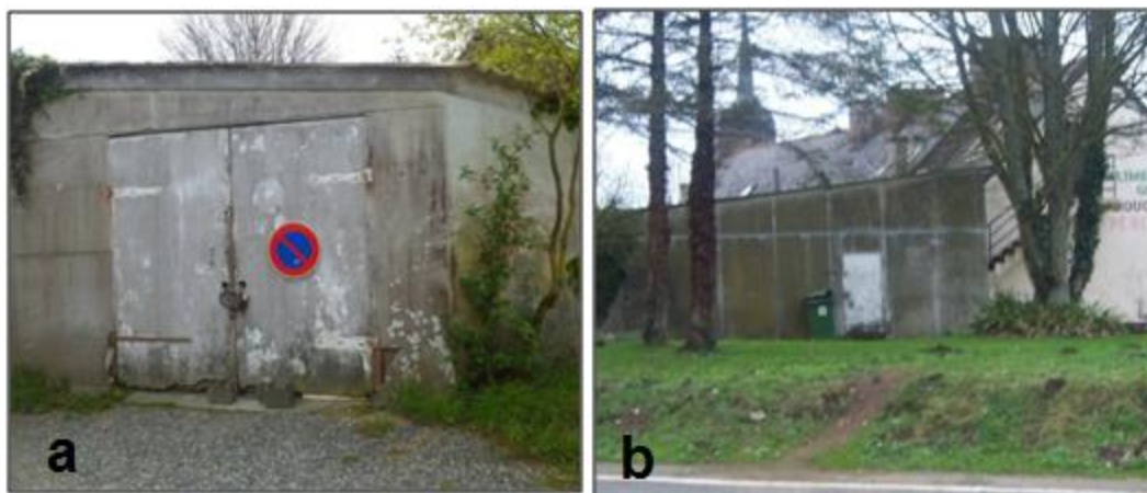
Photographie 21 : 21a, « Garage » ; 21b, hangard Source : Morgane BEUREL
