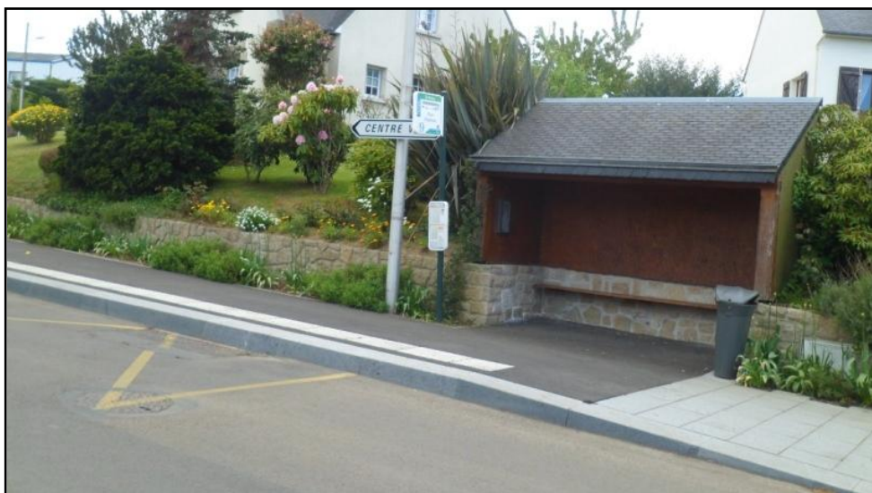
Photographie 41 : Exemple d'un arrêt de bus « en ligne » (zigzag, quai surélevé, BEV, abris bus) Source : Morgane BEUREL
