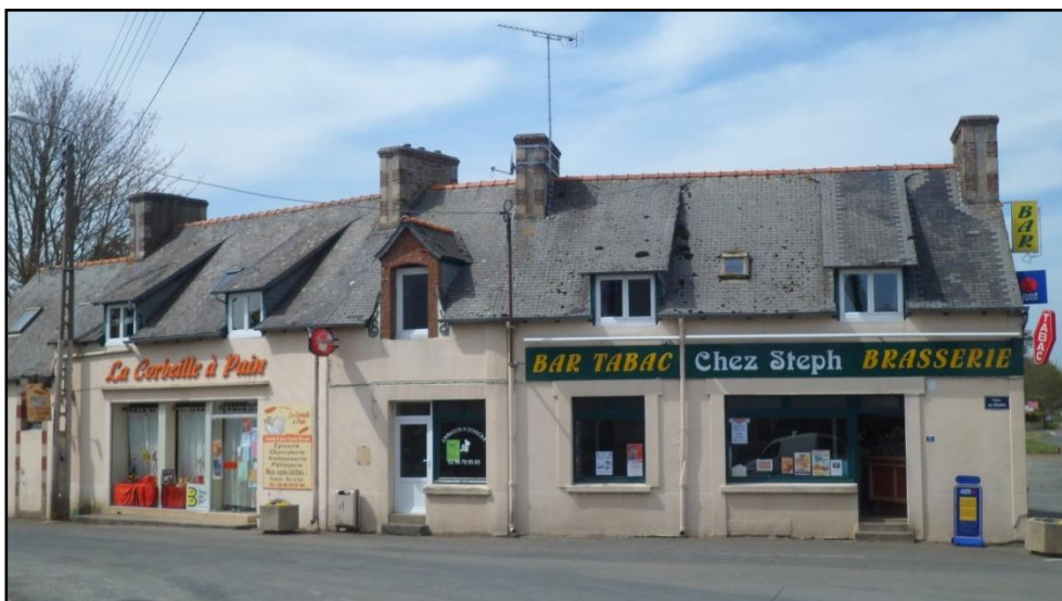
Photographie 19 : Les bâtiments actuels Source : Morgane BEUREL
