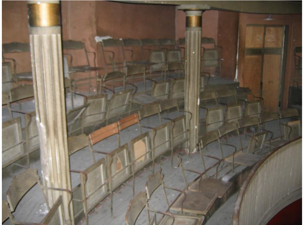
Figure 10 : Deuxième étage du théâtre, partie la plus vétuste (source : réalisation personnelle, 2013)
