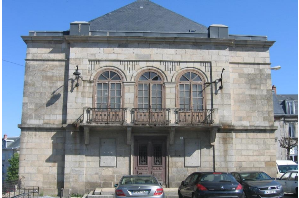
Figure 6 : Façade sud du théâtre (source : photo personnelle, 2013)
