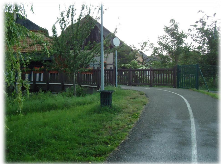
Photographie 20 : Exemple de pont présent sur la commune et à destination des circulations douces
