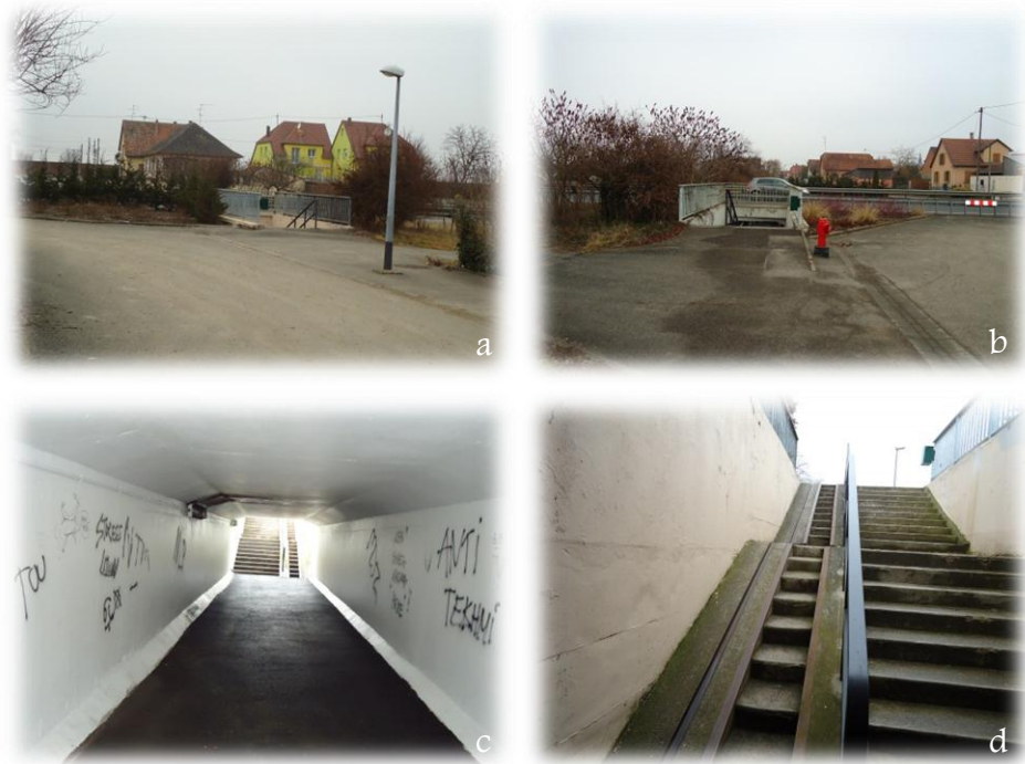
Photographies 12 : Passage souterrain reliant la gare au bourg : son intégration dans le paysage urbain (a&b), son aspect (c) et sa goulotte (d)
