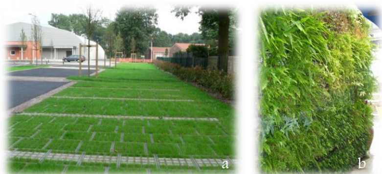
Photographies 23 : Exemple d'aménagements végétalisés : le parking engazonné (a) et le mur végétal (b)
