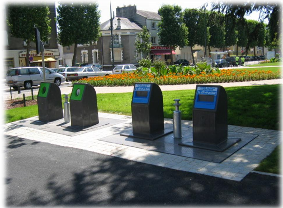
Photographie 24 : Exemple de conteneurs enterrés
