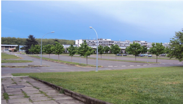
Faculté des sciences. Repère D3, UPS, 118 Route de Narbonne, Toulouse. Auteur : Salhi Mounia. Avril 2012.
