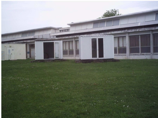
Faculté des sciences. Préfabriqués abandonnés. Repère D4, UPS, 118 Route de Narbonne, Toulouse. Auteur : Salhi Mounia. Avril 2012.
