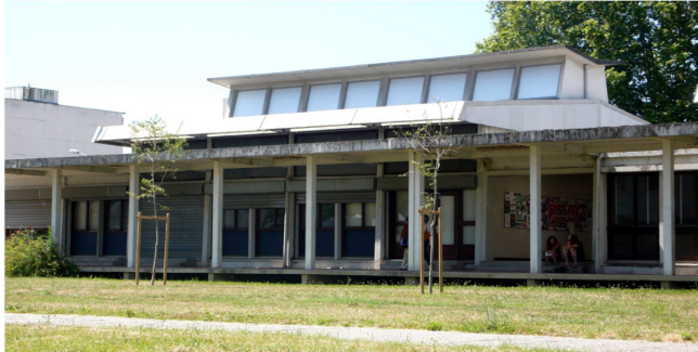
Salles de travaux dirigés mathématiques/informatique (ITP1) , René Egger, Architecte, Yannic Boudard, Collaborateur, Ferdinand Chabanne, Architecte d'opération.
