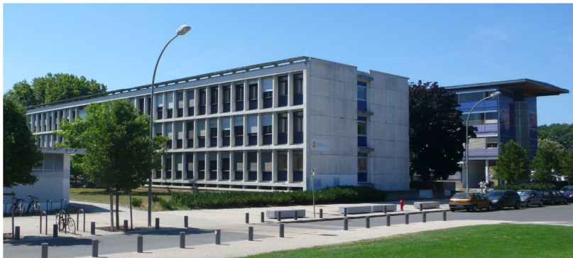
Laboratoire de recherche mathématiques/informatique, (1R2) , René Egger, Architecte, Yannic Boudard, Collaborateur, Ferdinand Chabanne, Architecte d'opération.
