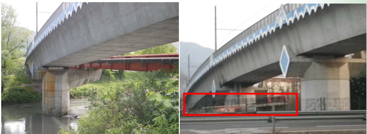
Photo 22 : Passerelle près du pont du tram
