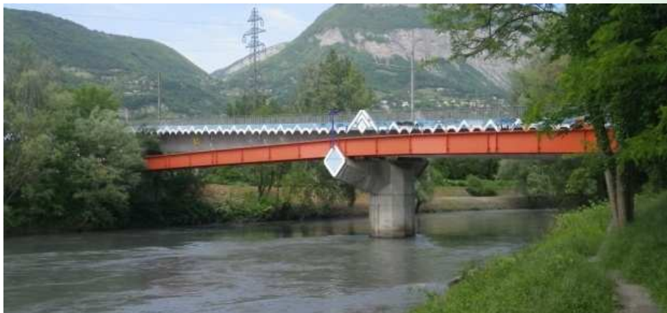
Photo 3 : Le pont de la N90 (en haut)/ le pont du tram
