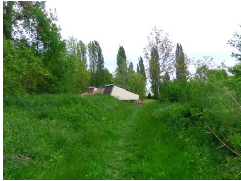
Photo 15 : Prise de vue n°3 du hangar à bateau
