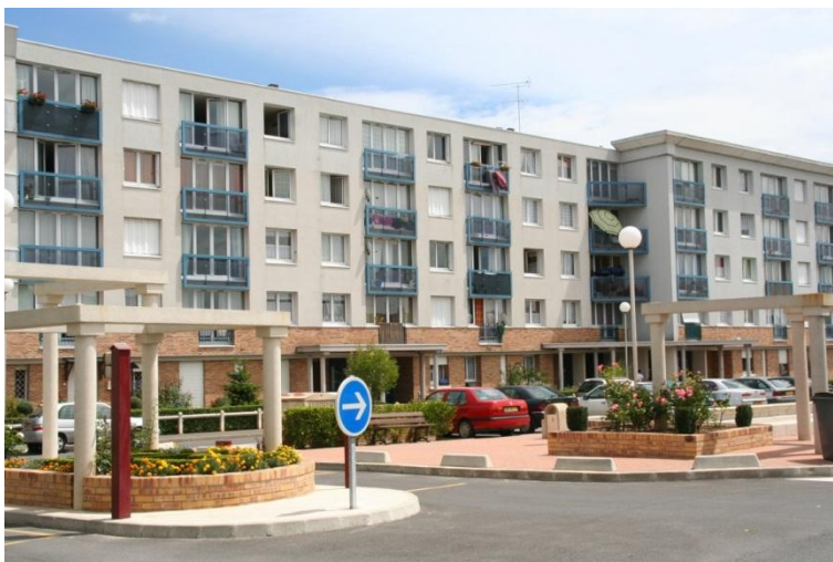
Photo 7 : Résidence HLM des Hauts de la Badaudière à Breuillet Source : Mairie de Breuillet
