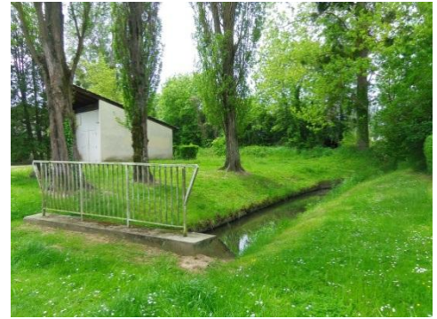
Photo 14 : Prise de vue n°2 du hangar à bateau
