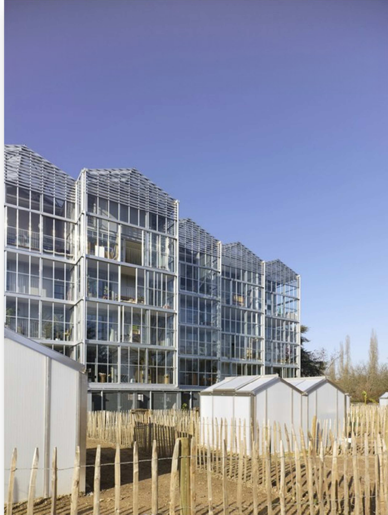
Figure 5 - Façades Sud du projet, avec balcons vitrés fortement exposés et jardins ouvriers
