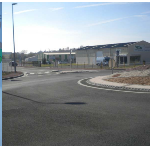
Figure 40 : L'entrée réaménagée de la ZA
