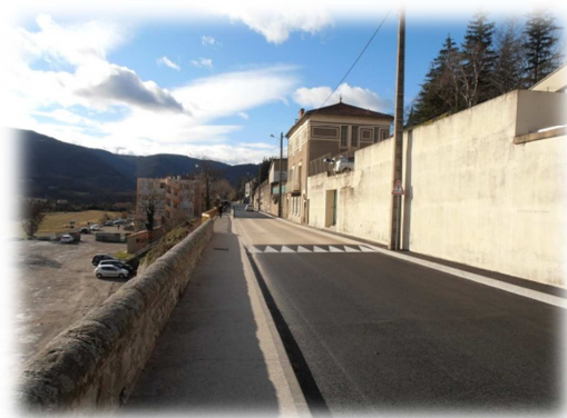
PHOTO 17 : RENOVATION D'UNE PARTIE DE LA ROUTE DES MINES AUTEUR : CORTIAL SYLVAIN
