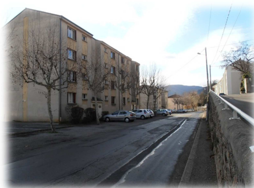
PHOTO 14 : ETAT DE LA ROUTE DES MINES NON RENOVE AUTEUR : CORTIAL SYLVAIN
