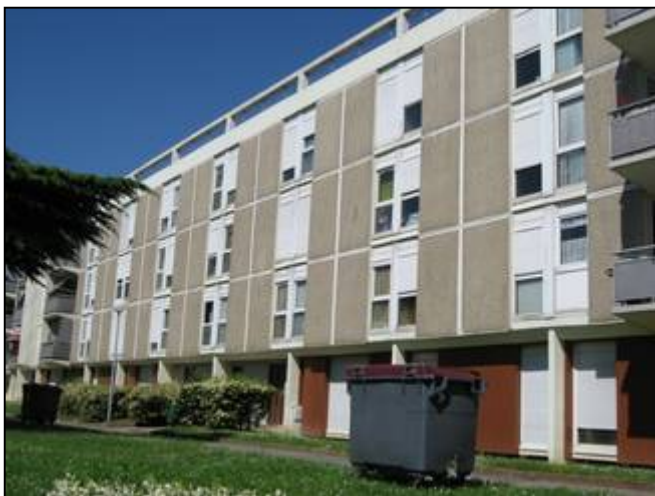
Photo 9 : Les logements sociaux du Grand Ensemble avant réhabilitation
