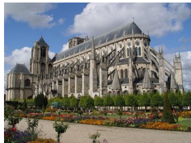
Figure 5 La cathédrale Saint-Etienne de Bourges, construite en partie avec du calcaire lacustre issu de la Chapelle Saint Ursin
