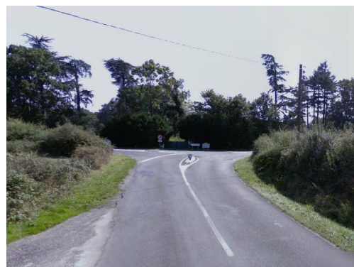
Figure 15 : route sinueuse et sans trottoir
