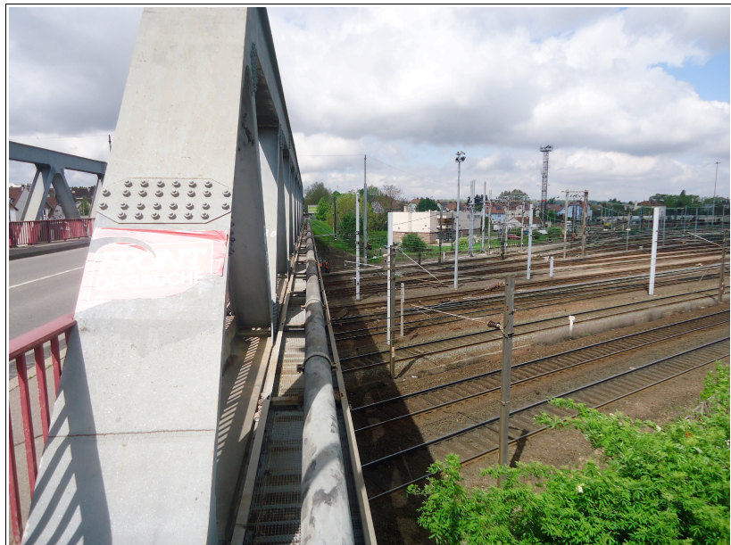
Illustration 32: Photographie des abords au nord - ouest du pont
