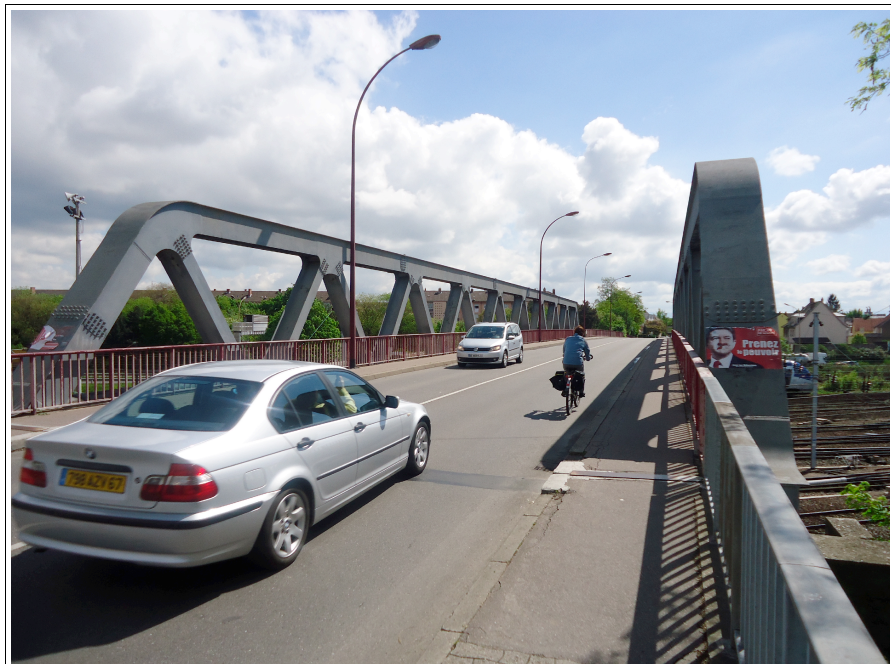
Illustration 30: Situation conflictuelle sur le pont Route de Hausbergen
