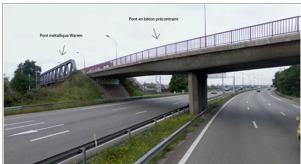
Illustration 33: Photographie du pont de Hausbergen
