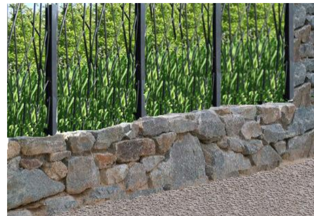
Figure 43 : Clôture de la parcelle (Réalisée par Oly ROBSOMANITRANDRASANA)
