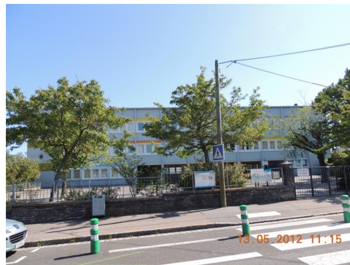
Figure 18 : Ecole Marcel Macé (Photo réalisée par Oly ROBSOMANITRANDRASANA)
