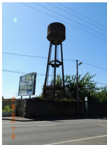
Figure 35 : Ancien réservoir d'eau de tenue maraîchère (Photo réalisée par Oly ROBSONANITRANDRASANA)
