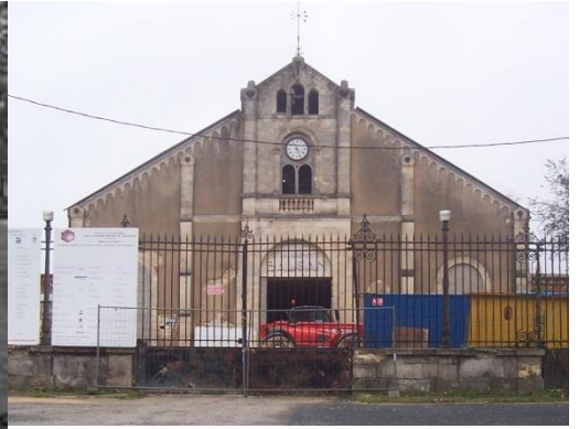
Figure 47 : Façade la partie centrale aujourd'hui
