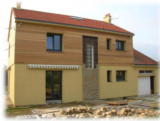
FIGURE 35: ENDUIT A LA CHAUX ET BARDAGE BOIS
