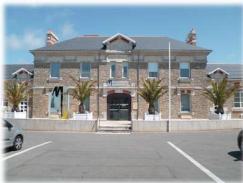
Illustration 24 : Médiathèque de Pornichet
