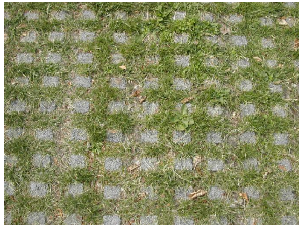
Photo 24 : Pavés de béton dans une matrice terreuse enherbée
