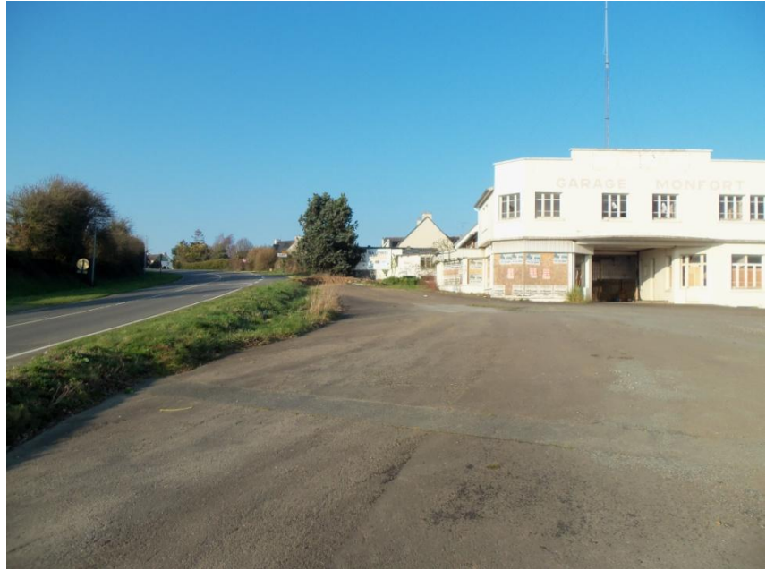
Photo 17 : Le garage abandonné et dégradé
