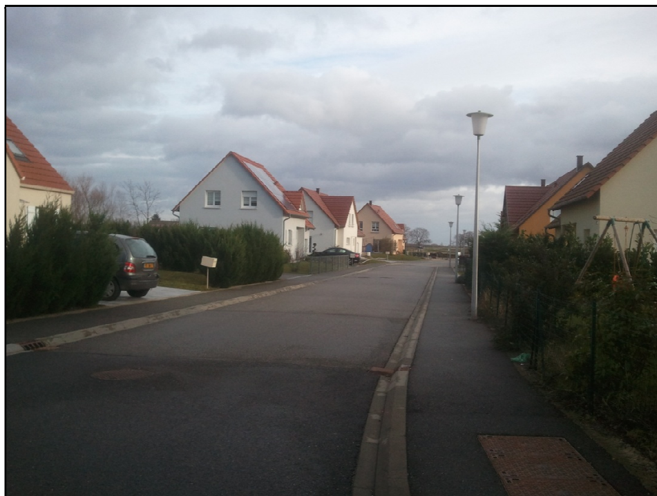
Image 12 : Maisons du Bodenfeld
