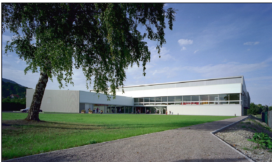
Image 4: Le centre sportif du Piémont (Source : weber-keiling.com)
