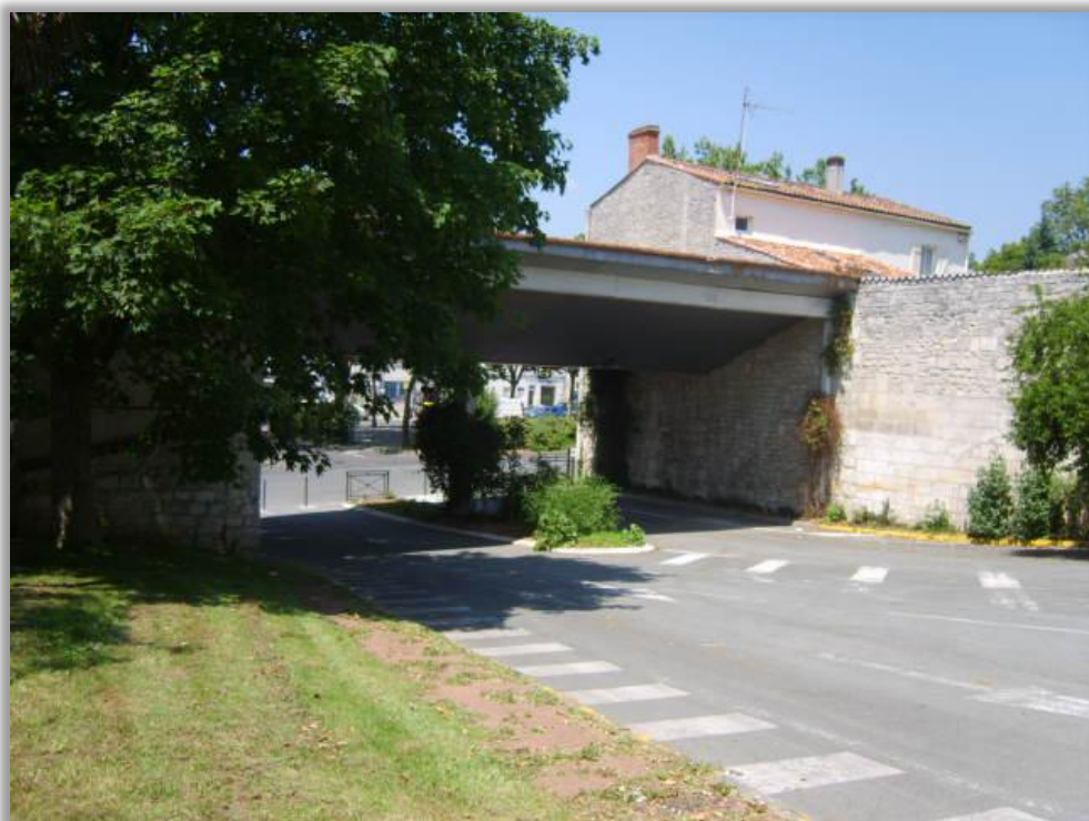
Photo 8: L'entrée actuelle, vue depuis l'intérieur du site Réalisation: Gabriela Iriart
