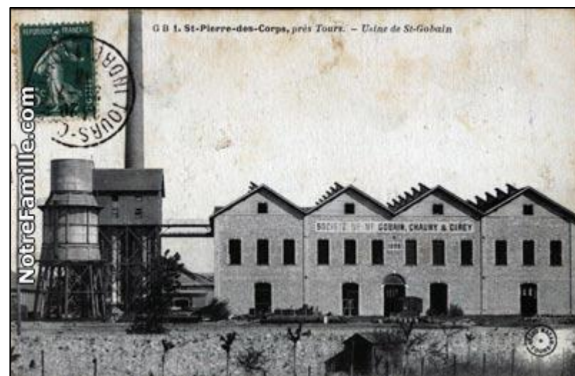
Figure 8 : L'usine de Saint-Gobain : le début de l'industrialisation de Saint-Pierre-des-Corps
