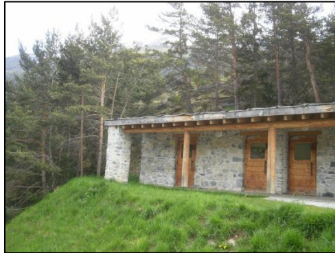
Figure 50 : Sanitaires à l'entrée nord du fort Victor-Emmanuel
