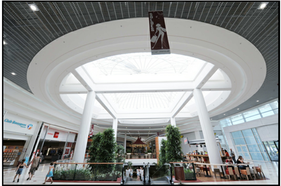
Photo 27 : exemple de puits de jour central
