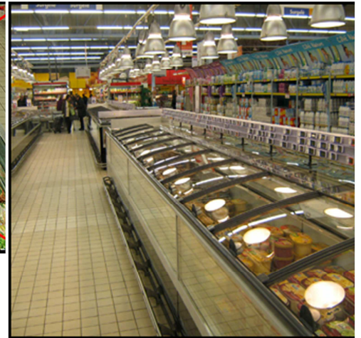
Photo 30 : bacs surgelés fermés
