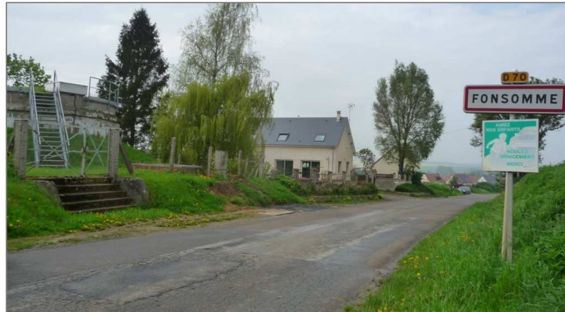
Figure 65 : Entrée dans Fonsomme par une route dégradée, sans marquage au sol et dont les bas-côtés sont mal entretenus (Entrée Fons 5)
