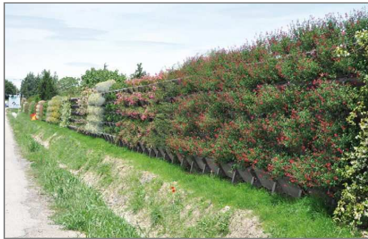
Figure 98 : Exemple de mur anti-bruit végétalisé sur la rocade d'Alès (30) Source : mine-temoin.fr
