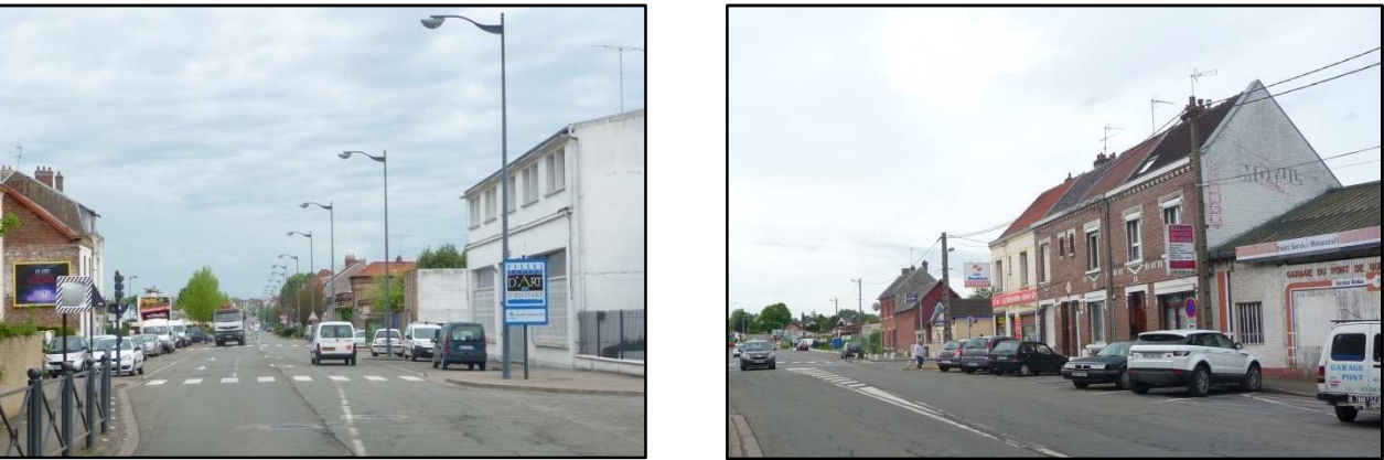
Figure 132 : Réseaux enterrés à Saint-Quentin (à gauche) et aériens à Neuville-Saint-Amand (à droite)
