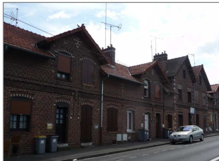
Figure 82 : Maisons en briques à Harly, rue de Guise
