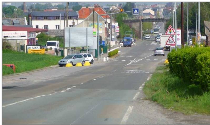
Figure 111 : Etat de la voirie dans Neuville-Saint-Amand
