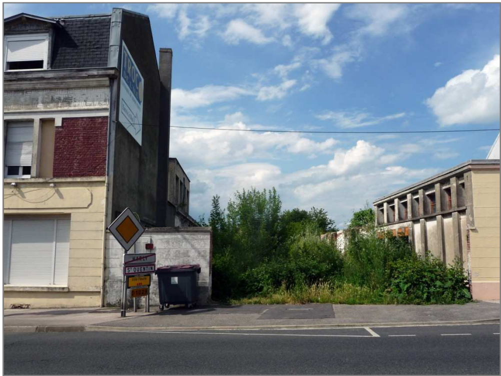
Figure 39 : Dent creuse au niveau de l'entrée de ville de Saint-Quentin en continuité urbaine avec Harly (StQ-Ha1)
