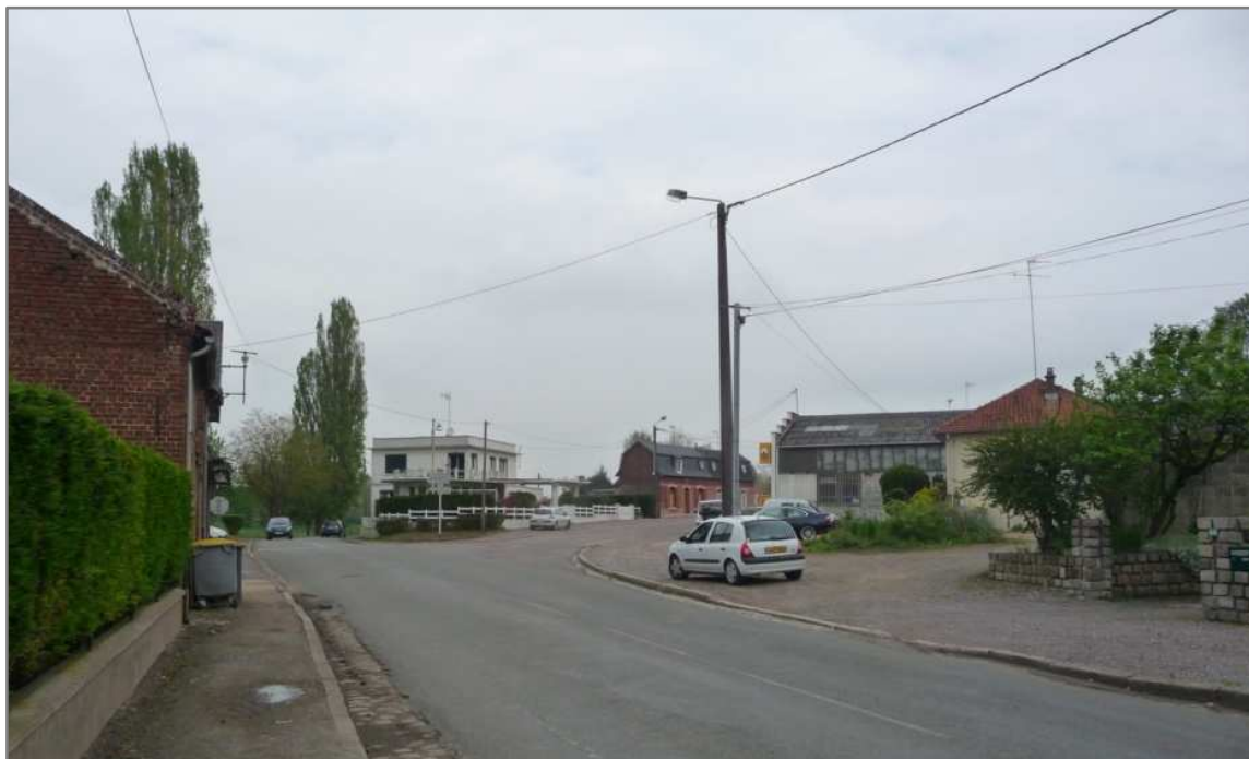
Figure 61 : Garage automobile peu entretenu en entrée de ville (Entrée L 4)
