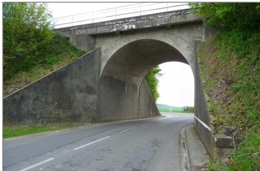
Figure 59 : Pont à l'entrée de la ville de Grugies, situé après le virage (Entrée Gr 2). Vue depuis Grugies
