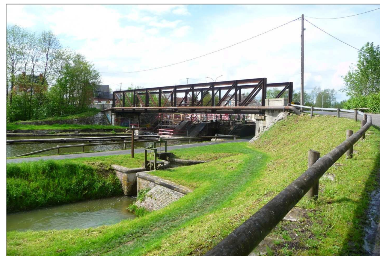
Figure 53 : L'écluse d'Omissy, entre Omissy et Morcourt (Entrée Om-Mor 4)
