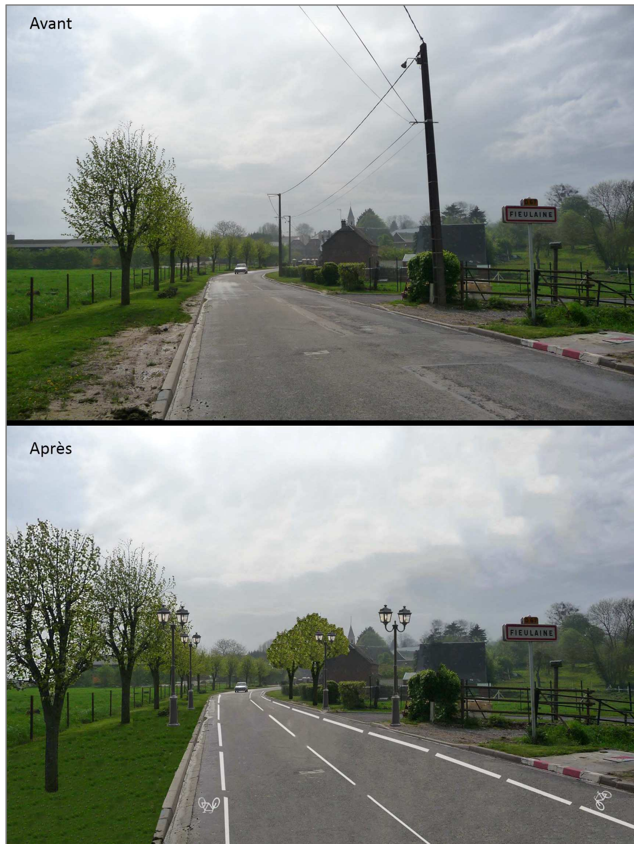
Figure 108 : Entrée de village entièrement réaménagée, Fieulaine (Fieu2)
