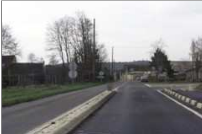
Figure 78 : Terre plein non franchissable Source : http://www.maxipermis.com
