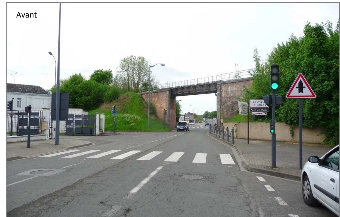
Figure 142 : Etat initial du pont de Guise
