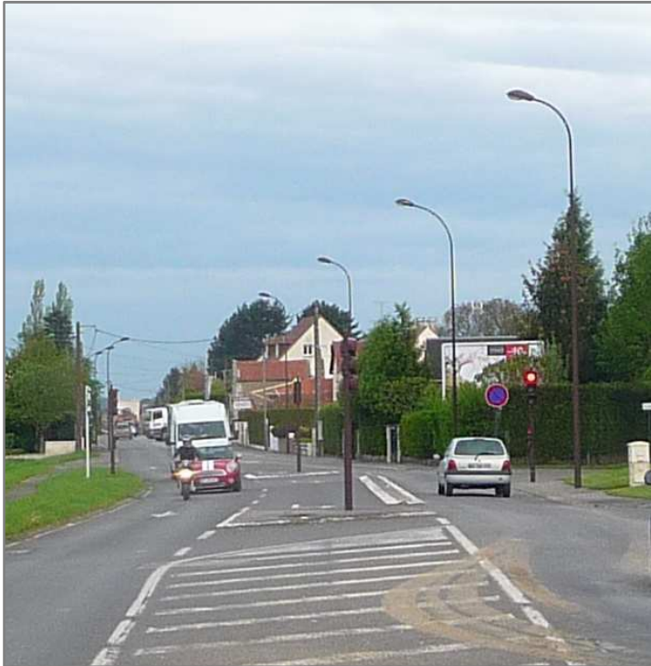
Figure 68 : Réseaux électriques non enterrés (Entrée StQ 7)
