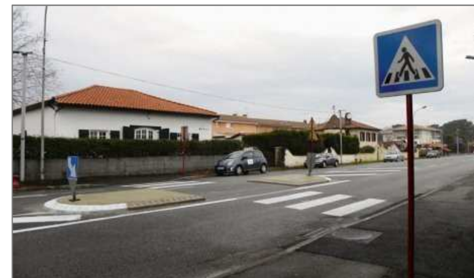
Figure 77 : Exemple de passage piéton en deux temps Source : tarnos.blogs.sudouest.fr
