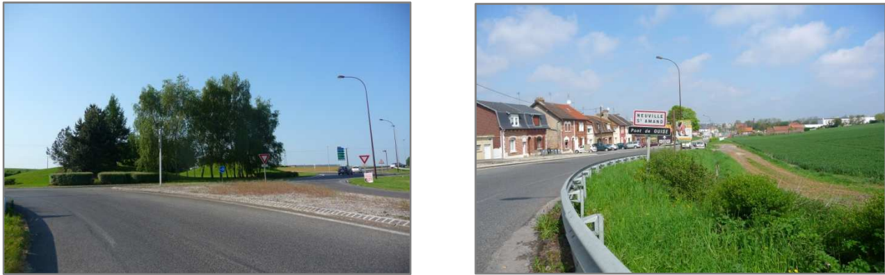
Figure 125 : Rond-point aménagé et terre-plein central à l'abandon
