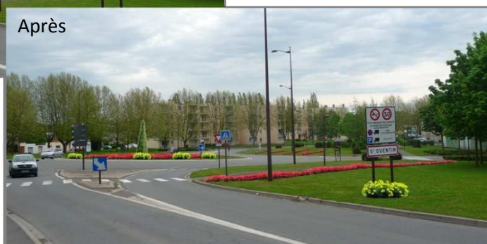
Figure 19 : Giratoire à l'entrée de Saint-Quentin
