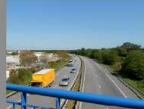
14 - St-Evarzec (Pont vue RN165)
