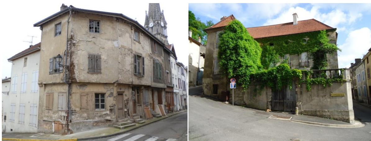
Illustration 1 : Exemples du patrimoine architectural dégradé de Joinville
