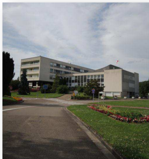
Image 61 : Centre Hospitalier du Tonnerre
