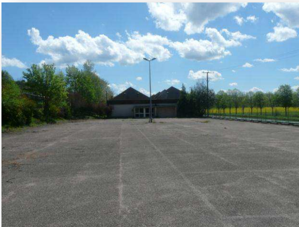
Image 70 : Ancien supermarché diagonal à Ravières Source : Colomb, Kerbellec, Ramond, Verneau
