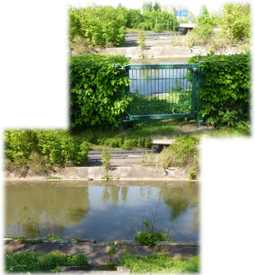
FIGURE 24 : LES BERGES DU CANAL ET LA PORTE D'ACCES DANS L'ÉTAT ACTUEL
