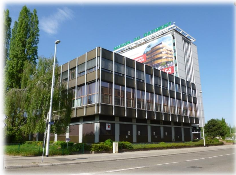
FIGURE 15 : LES DEUX BATIMENTS ABANDONNES A L'EST DE LA PLACE
