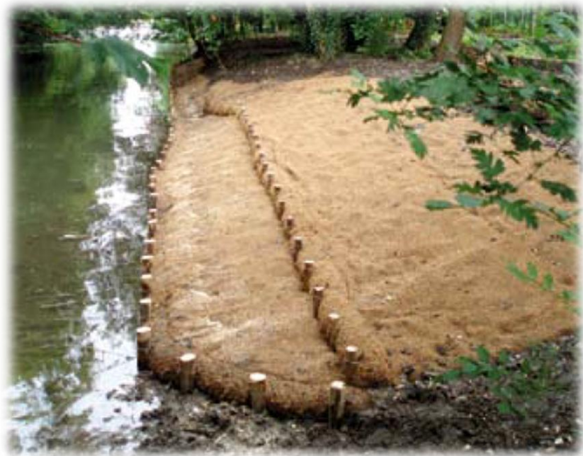
FIGURE 36 : EXEMPLE DE BERGE RECOUVERTE DE TOILE COCO AVANT VEGETALISATION SUR LES BORDS DE L'YERRES
