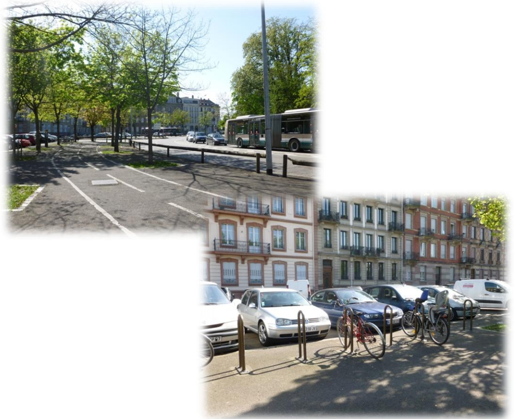
FIGURE 12 : TROTTOIR SE SITUANT DU COTE DES PLACES DE STATIONNEMENT
