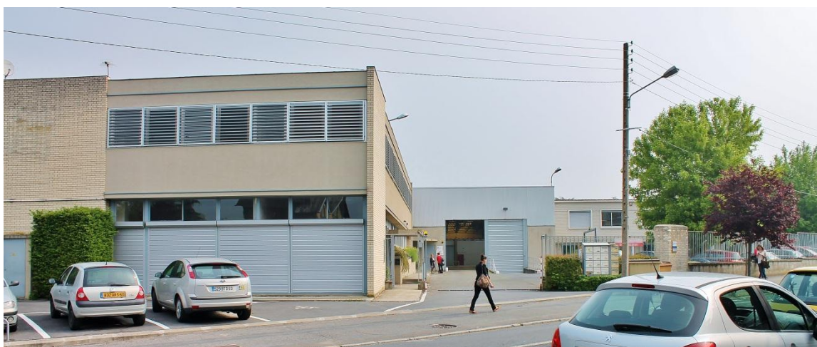
Figure 21: photo des entrepôts sous occupé et des bureaux Source : PRUCHE Hadrien
