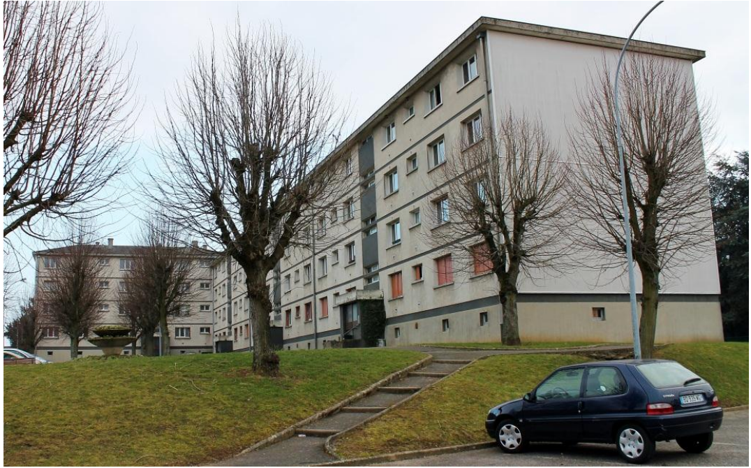
Figure 38 : Photo des logements collectifs appartenant à la municipalité Source : Hadrien PRUCHE
