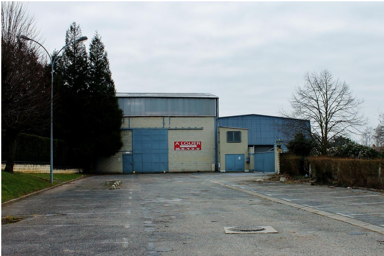
Figure 22 : Photo de la friche industrielle (ancienne sidérurgie)
