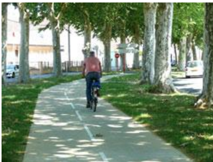
Figure 49 : Photo d'une piste cyclable en béton désactivé à Villeneuve sur Lot Source : http://www.ville-villeneuve-sur-lot.fr/action-bastide-l%E2%80%99avenir-s%E2%80%99installe-en-centre-ville-art261.html
