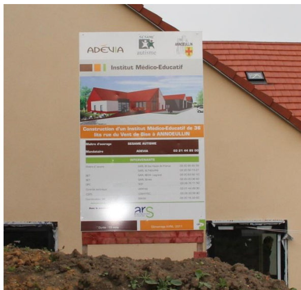
FIGURE 20 : L'INSTITUT MEDICO EDUCATIF EN CONSTRUCTION
