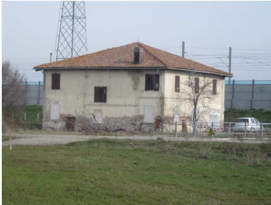
Photo 2 : Maison destinée à accueillir scolaires et groupes sur le thème du photovoltaïque
