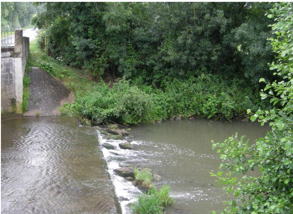
Rochers en berge rive gauche
