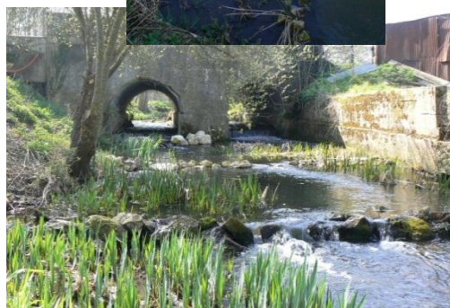
Décomposition de la chute par des petits seuils en enrochements
