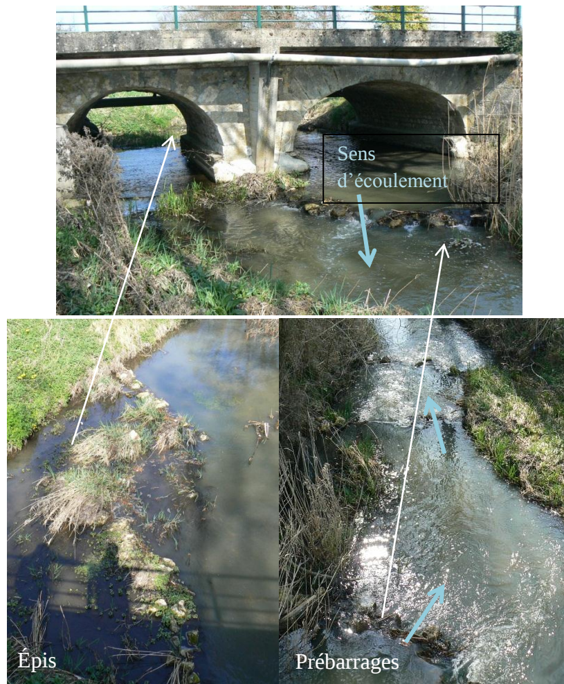
Figure 12 : Aménagement de prébarrages à Pernay sur la Bresme : vue aval et vues de haut (source : CG37)
