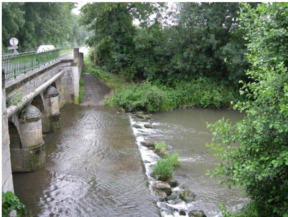
Aval de l'ouvrage
