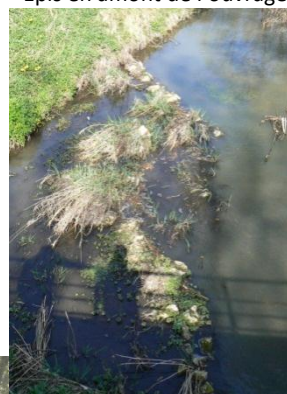
Épis en amont de l'ouvrage
