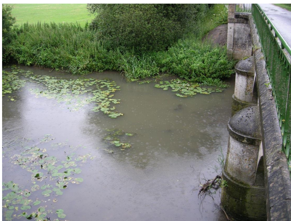
Amont de l'ouvrage
