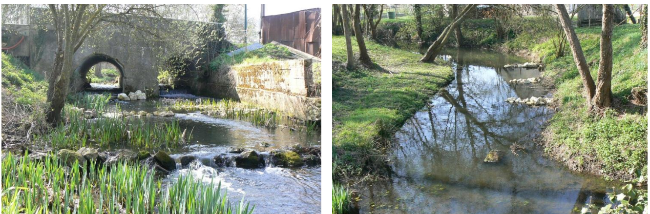
Figure 13 : Aménagement de Villiers-au-Bouin : prébarrages en enrochements à l'aval et épis à l'amont (source : CG37)
