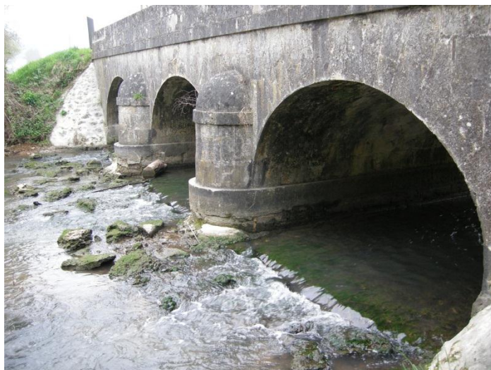
Figure 11 : Enrochements mis en place pour limiter la chute en aval du radier à Noizay sur la Cisse (source : L. Levieuge)
