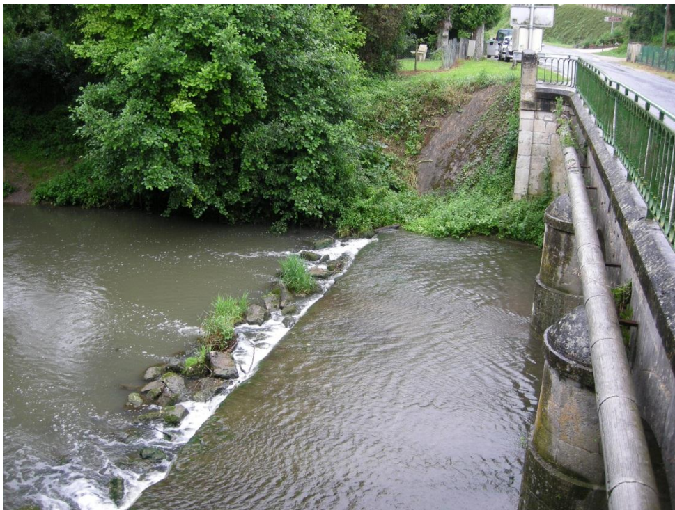
Aval rive droite
