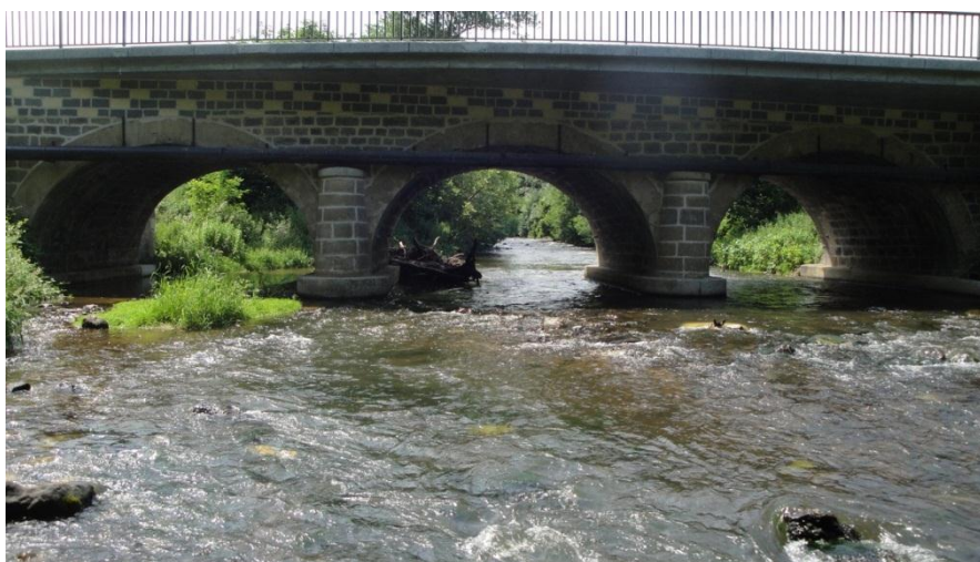
Figure 17 : vue aval du pont de la RD 229 le 18/06/2012 (source : PA Gombault)
