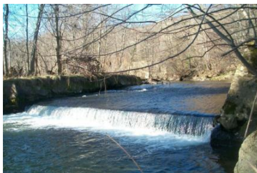
Figure 19 : vue aval du seuil de l'ASA de la Ribeyre à l'étiage (source : com com Couze Val d'Allier)
