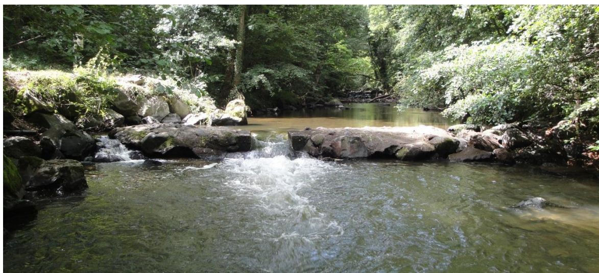
Figure 35 : vue du seuil d'irrigation à l'étiage le 09/08/2012 (source : PA Gombault)
