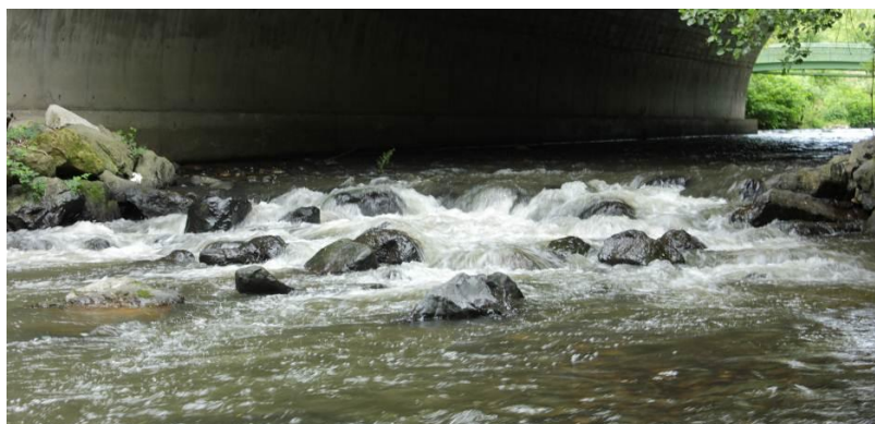
Figure 15 : photo du radier du pont de l'autoroute A 75 (source : PA Gombault)
