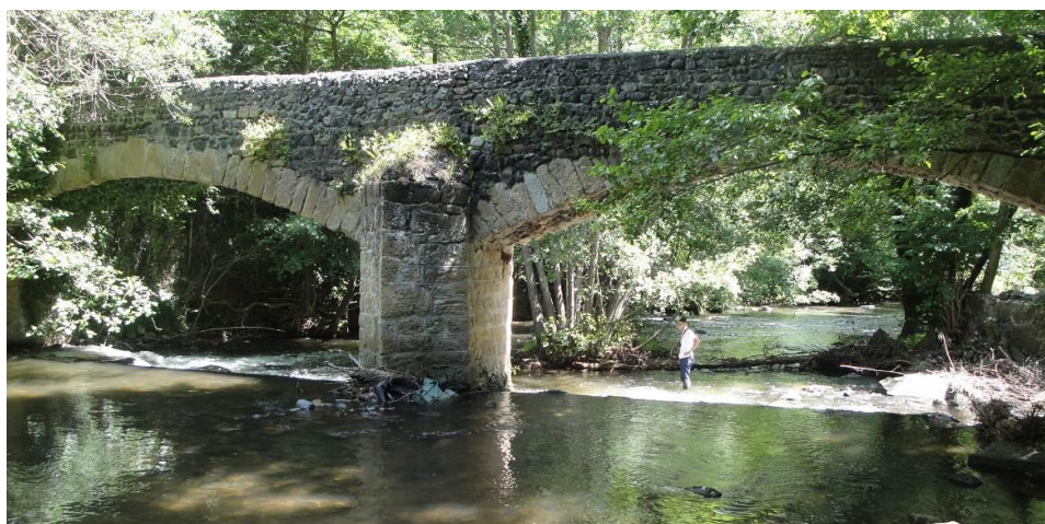
Figure 33 : photo amont du pont des Croix Basses le 06/06/2012 (source : PA Gombault)
