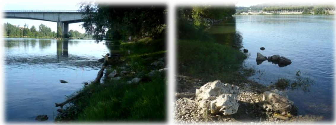
Photos de la station d'Agen, à gauche, vue vers l'amont, à droite, vue vers l'aval.
