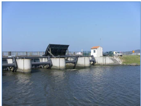
Vue amont – porte ouverte
