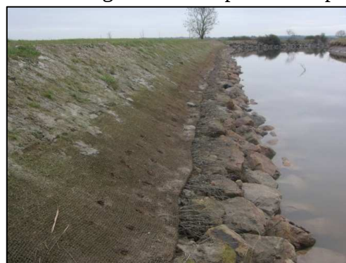
Figure 30: Protections de berges en amont du Clapet de l'Etoile du Marais
