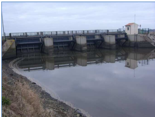
Vue amont – portes fermées
