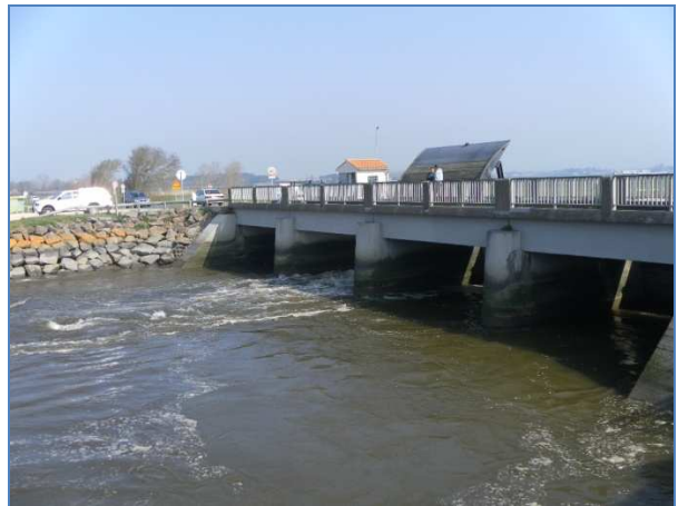
Vue aval – porte ouverte
