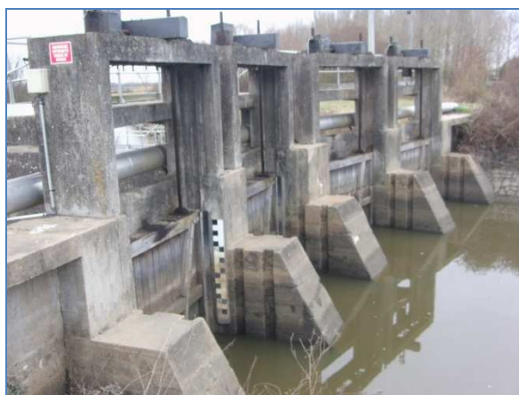
Vue aval – niveau bas
