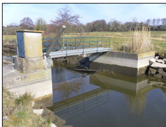
Figure 11: Passe à civelles installée sur le clapet de la Boissonnière (Jaunay)
