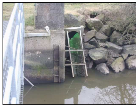
Figure 19: Passe à civelles de l'Ecluse de la Pinsonnière
