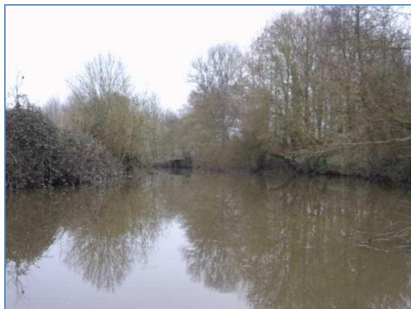
Photographie du bief amont
