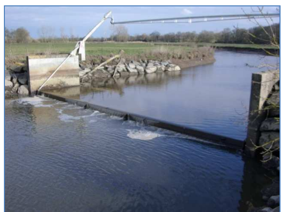
Vue aval – niveau bas
