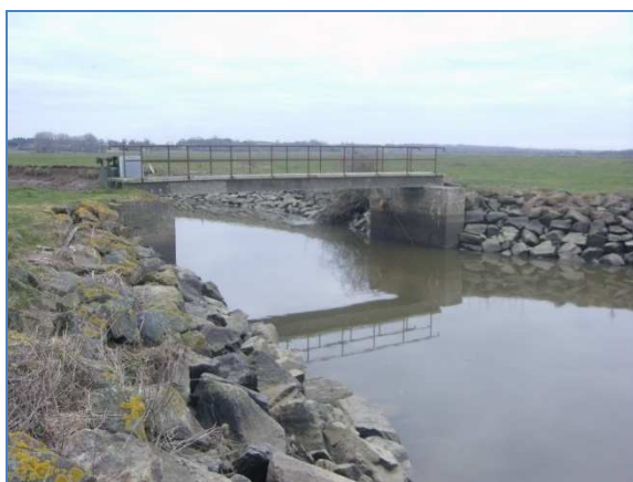
Vue amont – niveau bas
