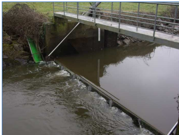
Vue aval – niveau bas
