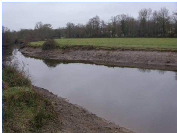
Photographie du bief amont – niveau bas
