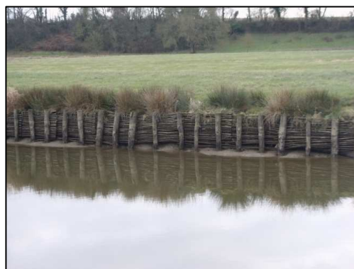
Figure 24: Protection de berges sur le bief du Clapet de la Vallée
