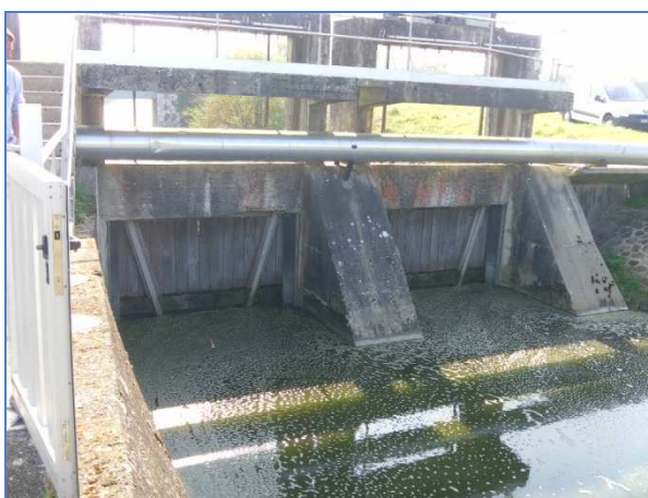
Vue amont – Ecours de l'Isle
