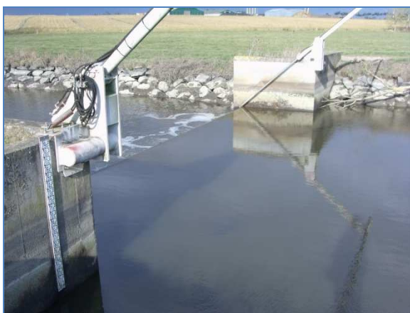
Vue amont – niveau bas
