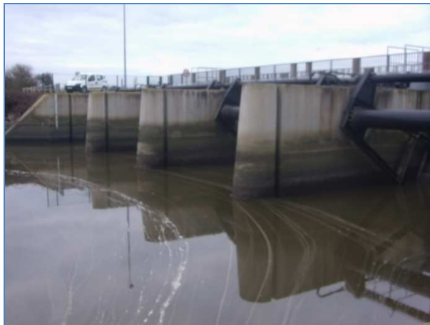
Vue aval – portes fermées
