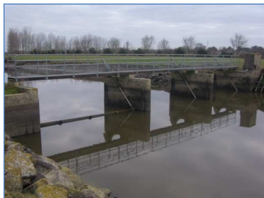
Vue aval – niveau bas
