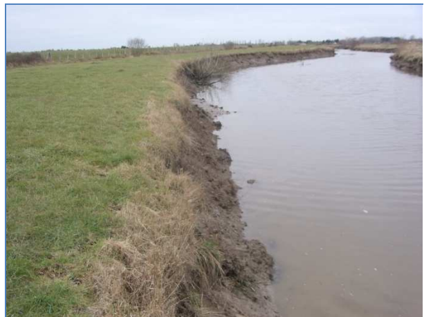
Photographie du bief amont (Ligneron)
