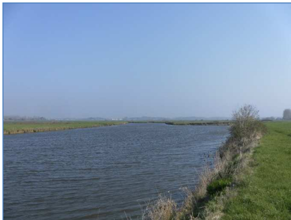
Photographie du bief amont
