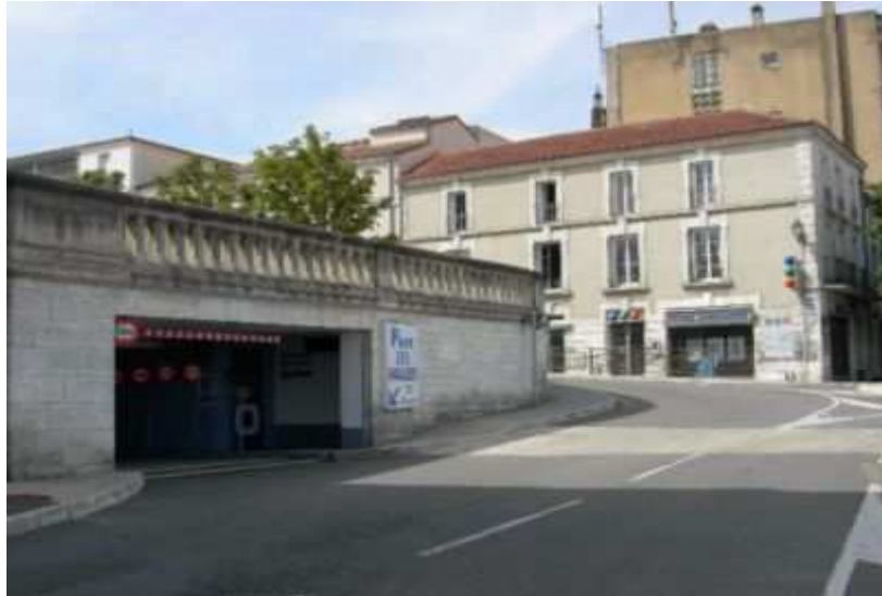
Figure 43: exemple d'entrée de parking souterrain à pente douce, épousant le relief du terrain
