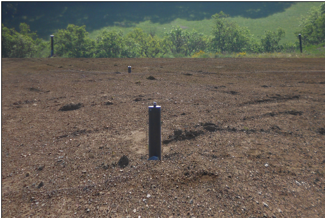
Photo 12 : Montage Photoshop de la couverture du casier DI 3 par 50 cm de terre, auteur : RICHARD Joan.
