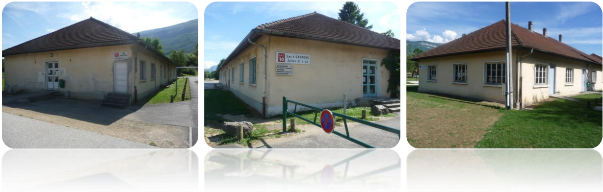
Photos 11, 12, 13 : Vue extérieure des bâtiments réhabilités
