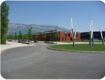
Photo 10 : Pôle montagne et Halle Emile Allais au fond
