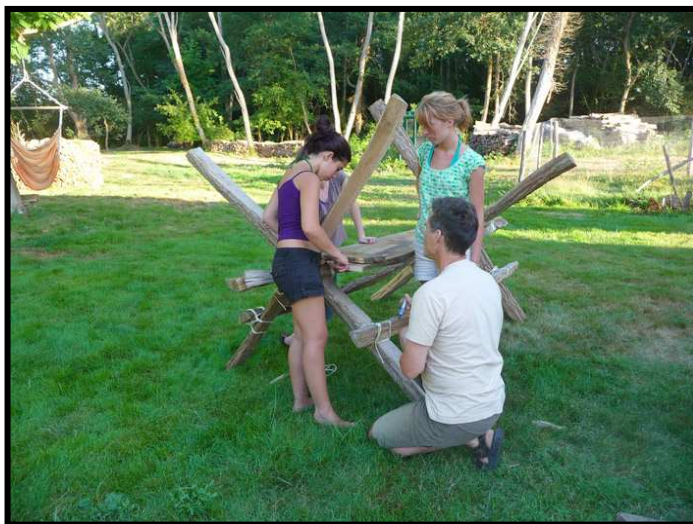
Photo 35 : Exemple d'espace de construction.
