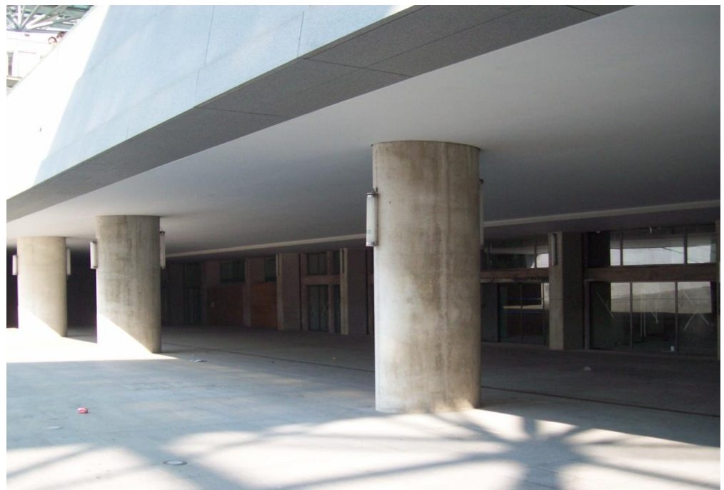
Photo 21 : Vue de l'accès aux quais depuis la place, Source Camille Elamine
