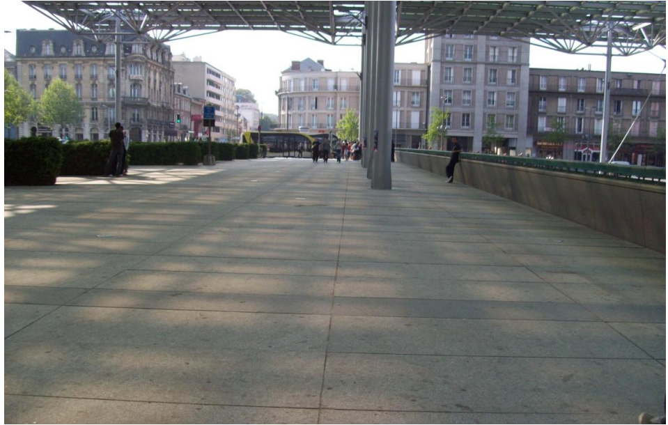
Photo 23 : Côté Sud de la place, Source Camille Elamine
